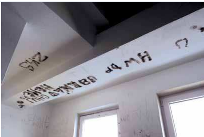
Klatki w budynkach przed remontem....
