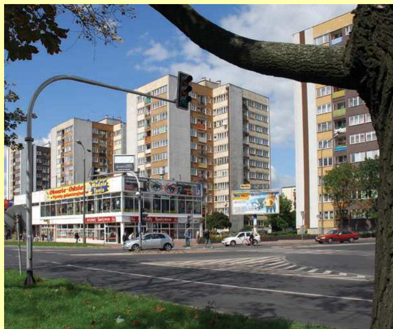
Widok na ul. Kobylińskiego i budynki ul. Piasta-Kołodzieja
