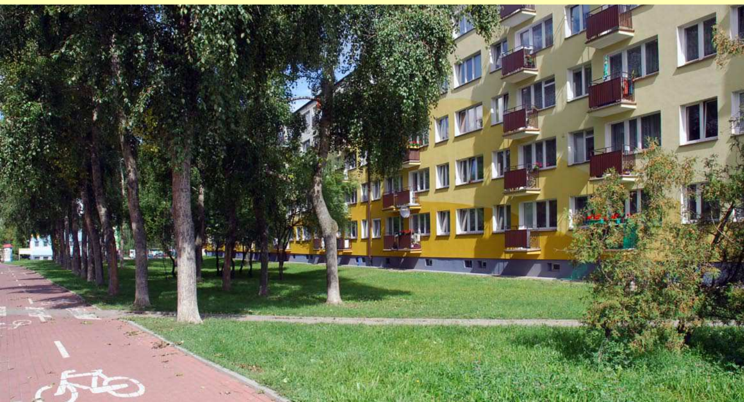
Budynek Łukasiewicza 26 poddany termomodernizacji w roku 2005.
